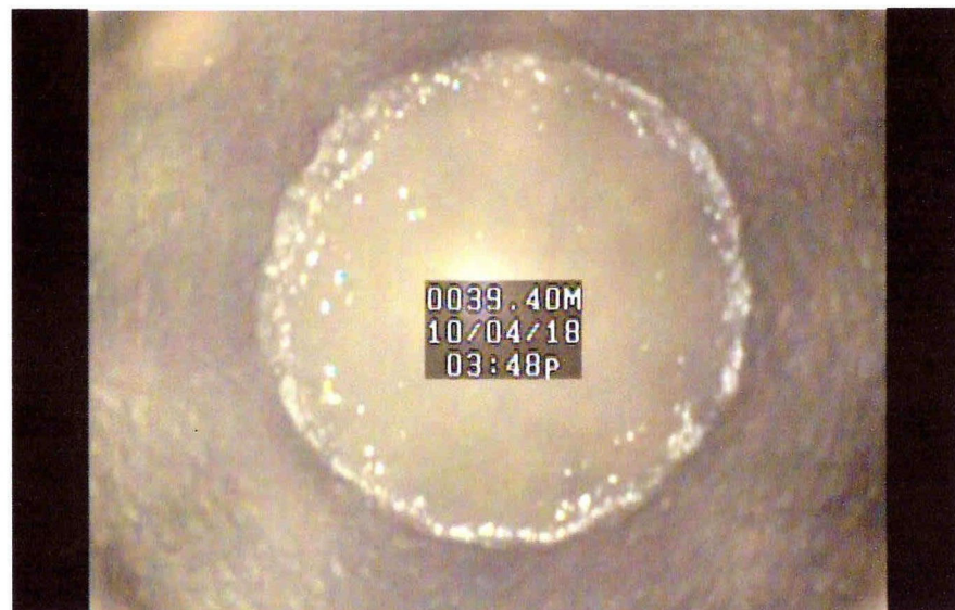
Imagen Después de 7 m3 Adicionales de Concreto
