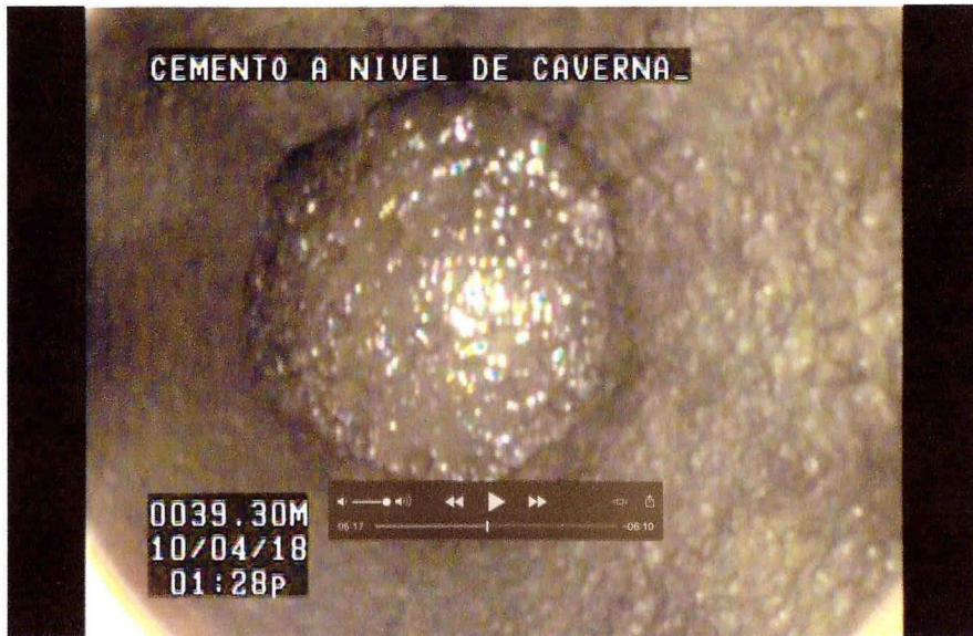
Imagen Después de 14 m3 de Concreto
