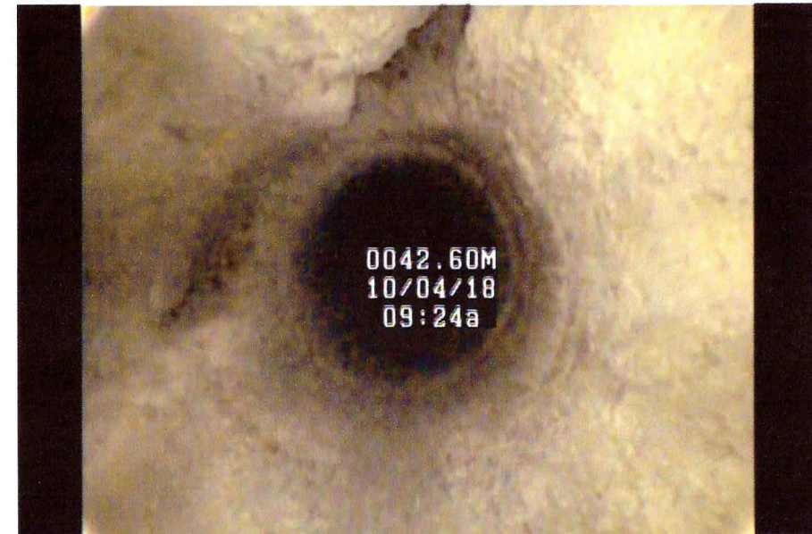
Imagen Vertical de la Terminación de la Caverna
