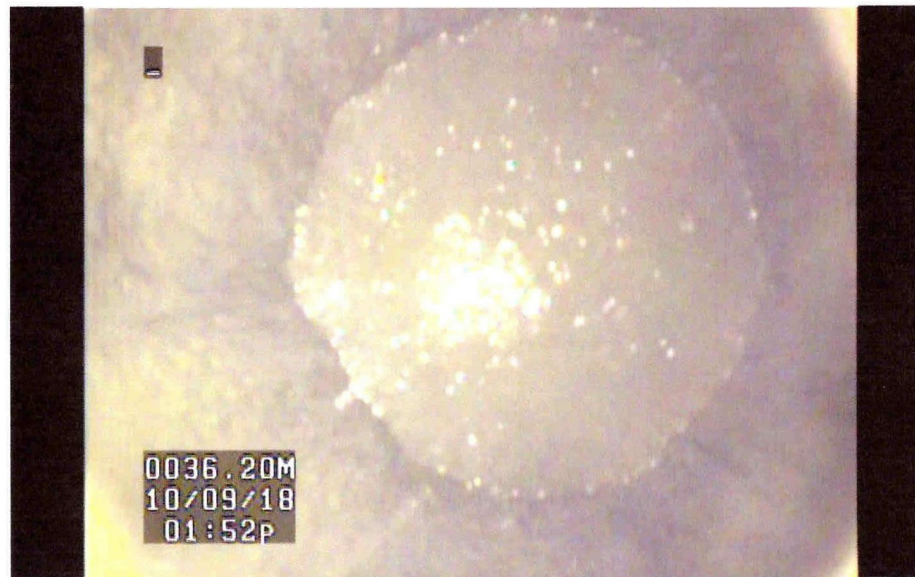
Imagen Vertical Después de 7 m3 Adicionales de Concreto
